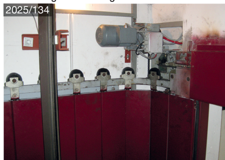
Meiller segment sliding door GTS6 central
